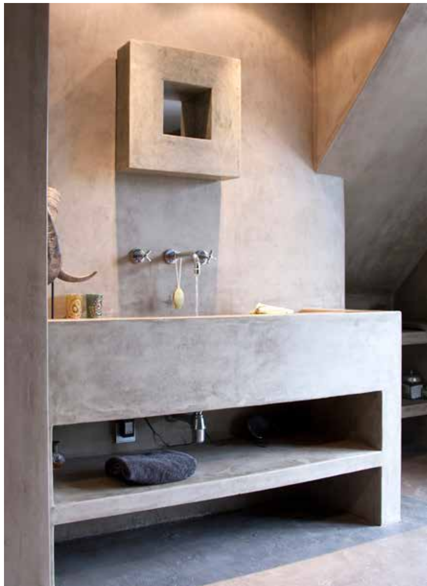
Dankzij de afwerking met tadelakt oogt de badkamer extra warm.
